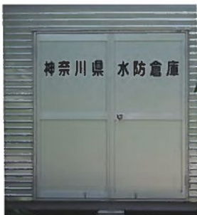
大口土手の水防倉庫
